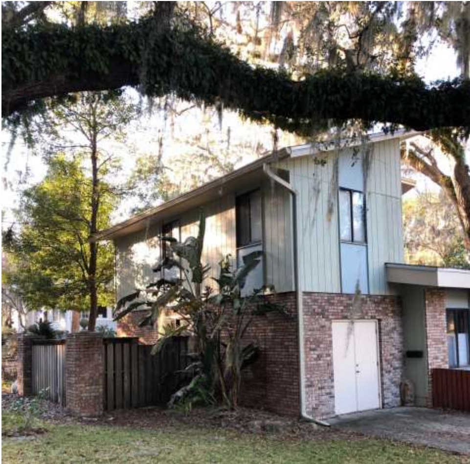
Fig. 5-18 510 NE Blvd. (AL05907)
